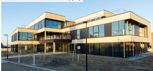
La Pilaterie – Villeneuve-d'Ascq (59)
