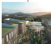
Hôpital Privé Maizières-Lès-Metz (57)
